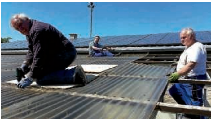
Demontage der Bedachung
